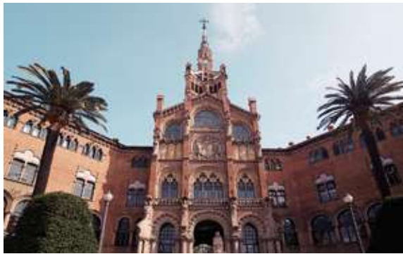
NOU HOSPITAL DE LA SANTA CREU I SANT PAU Barcelona, SPAIN
